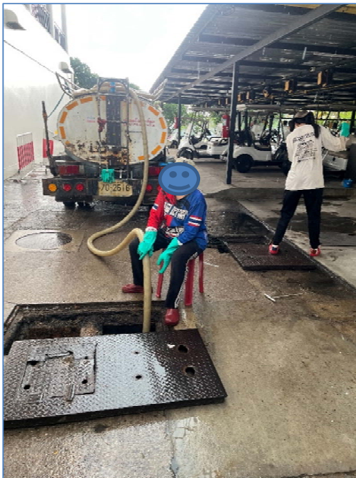
รูปที่ 1.6 การสูบลบการตะกอนออกจากระบบบำบัดไปกำจัด
