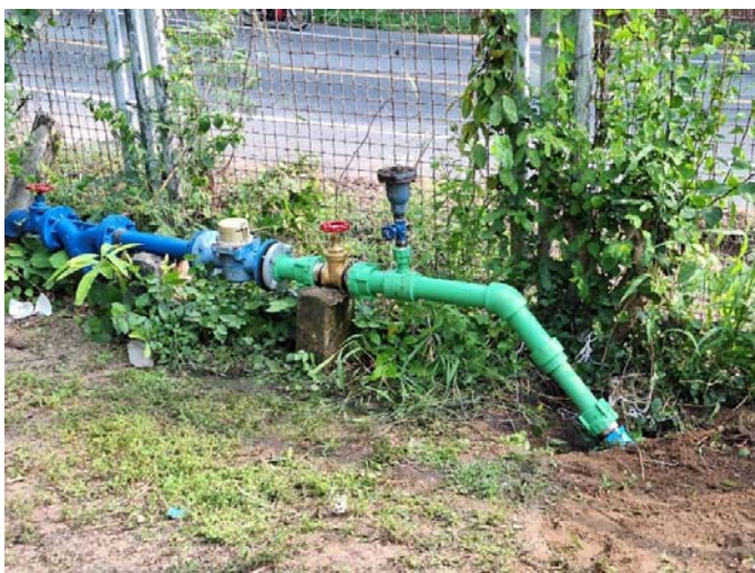
รูปที่ 2.1 ตรวจสอบรอยแตก/ชำรุดของระบบจ่ายน้ำ และระบบเส้นท่อประปาให้อยู่ในสภาพดีอยู่เสมอ
