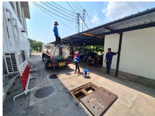
รูปที่ 1.6 การสูบลบการตะกอนออกจากระบบบำบัดไปกำจัด
