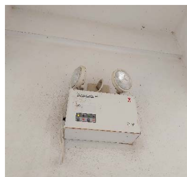
รูปที่ 3.2(6) ตรวจสอบชุดไฟฉุกเฉิน
